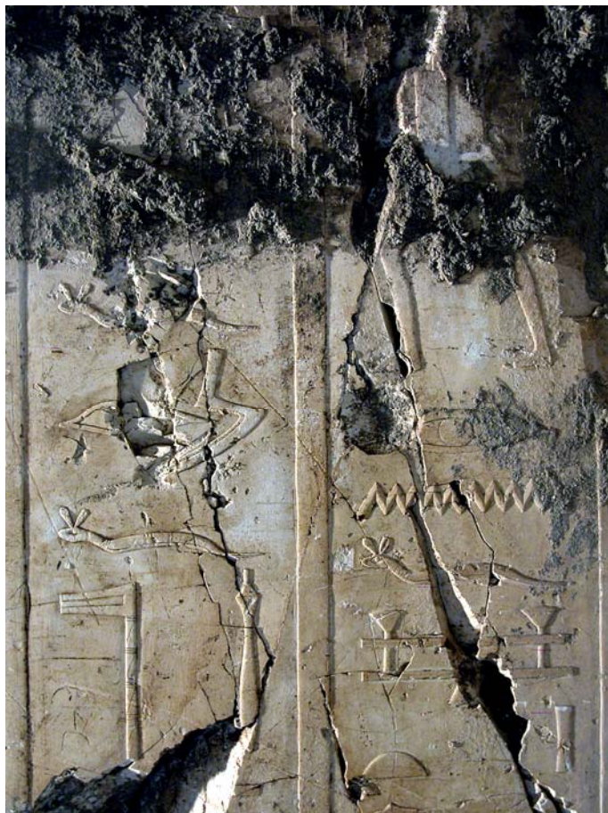
Fig. 1: particolare di un'iscrizione del vestibolo in corso di pulitura
